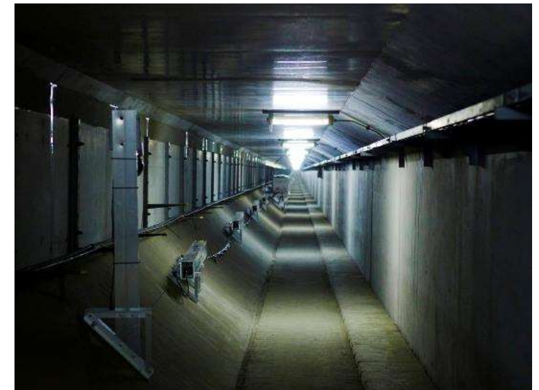
2021年末までに、100を超えるセンサーモジュールが 海面下45mのトンネルに整備される予定
